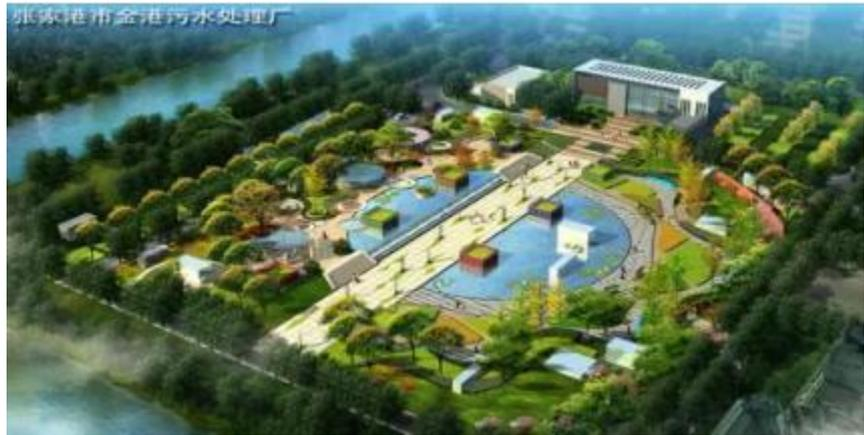
本工程项目扩建规模为 2.5 万  $\text{m}^3/\text{d}$ ，处理工艺采用“ $\text{A}^2/\text{O}+\text{MBBR}$  生化池+MBR 膜池”工艺。主要建设内容包括细格栅及精细格栅改造、沉砂池改造、二期生化池设备安装、二期 MBR 膜池设备安装、鼓风机房改造、药库及加药系统改造、污泥脱水机房改造、二期除臭系统设备安装及部分土建改造等。
