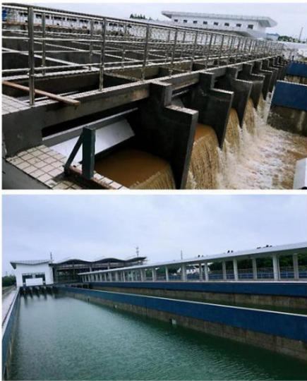
第四水厂扩建工程建设规模为20万立方米/日，包括取水工程、净水厂工程和清水主干管工程三部分。工程采用“高锰酸盐预氧化+机械混合折板絮凝平流沉淀+超滤+纳滤(部分)+消毒”的净水工艺。目前，扩建工程土建、设备安装基本完成，进入调试阶段。
